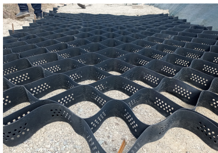
е) укріплення стежки на схилівій частині рекреаційної ділянки, георешітка; фото – М. Дребет
