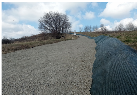
д) укріплення стежки на схилівій частині рекреаційної ділянки; фото – М. Дребет
