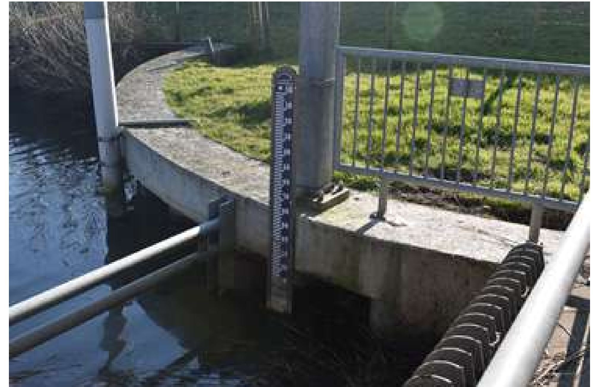
Рис. 1. Приклад невеликої гідроспоруди, оснащеної водомірною рейкою.
