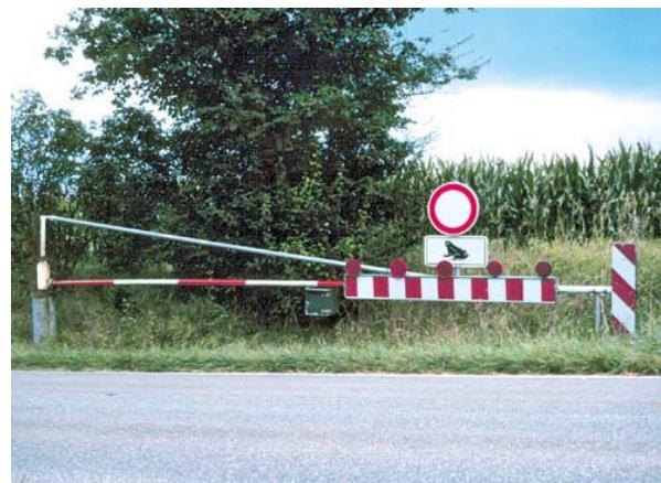
**Фото 64.** Шлагбаум (із попереджувальними знаками) для закриття місцевої дороги під час міграції земноводних (Німеччина)
