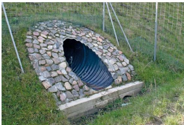
**Фото 91.** Бетонний поріг суттєво заважає амфібіям потрапляти до проходу
