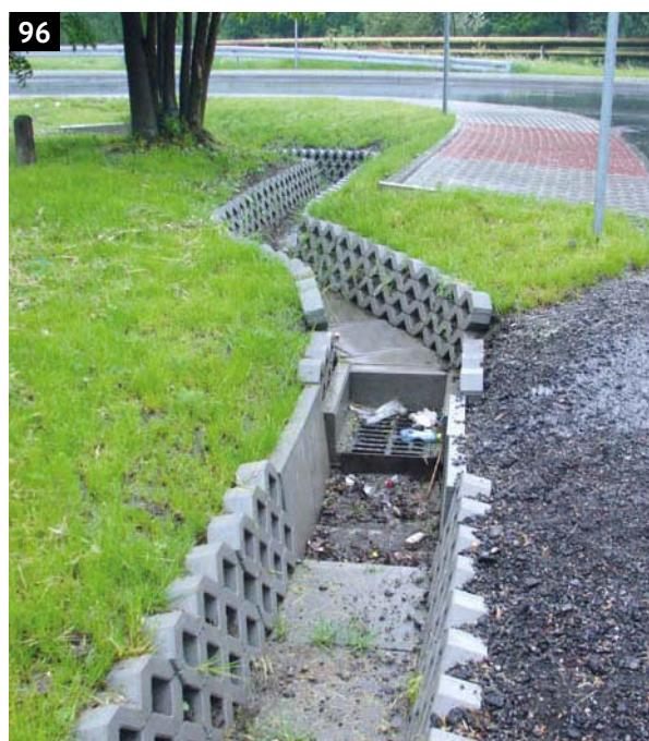
**Фото 93.** Приклад водозбірника, який є смертельною пасткою для земноводних
